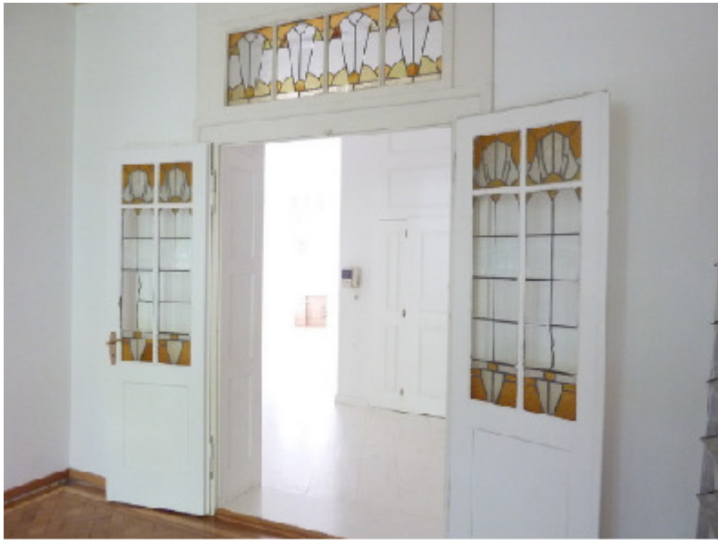
Oberlichtfenster. Ottikerstr. 24, 8006 Zürich (1906)
