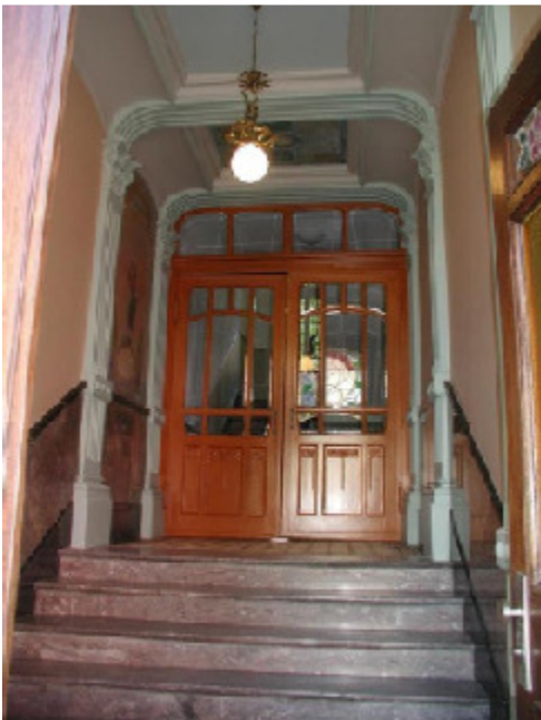
Zugangstreppe. Volkmarstr. 4, 8006 Zürich (1905)
